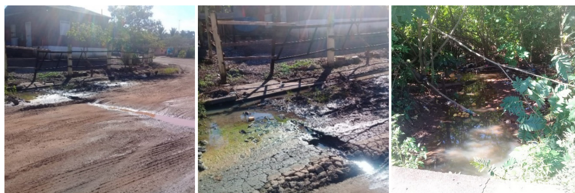
Figura 6 - Presença de escoamento de águas provenientes de esgoto e pluvial nas laterais das ruas na comunidade da CANP, Monte Alegre, Pará
