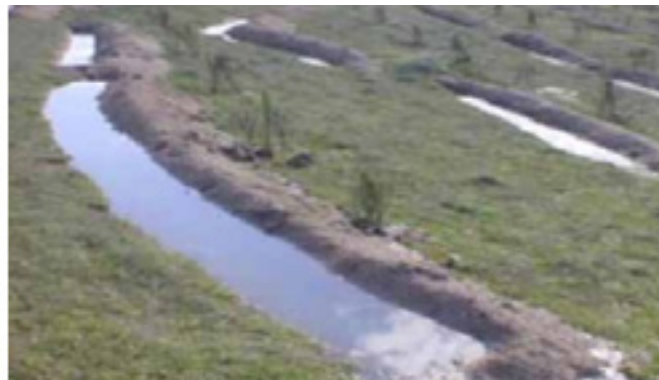
Figura 4b: Valas de infiltração
