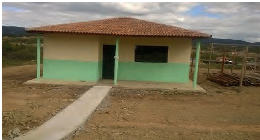
Figura 2 – Casa em construção na vila Cacaré
