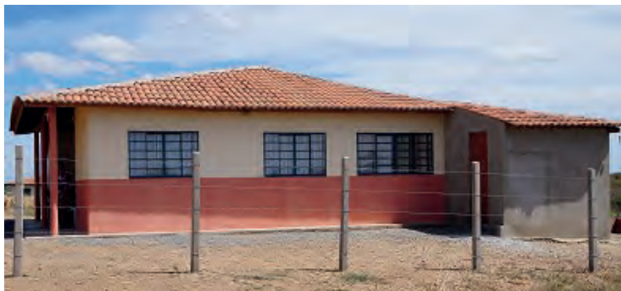
Figura 3 – Casa na vila Cacaré após edificação de um cômodo anexo (mercadinho)
