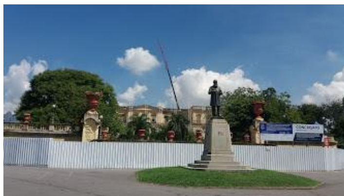
Figura 8. Museu Nacional em obras de restauração de seu prédio, em 2019.
